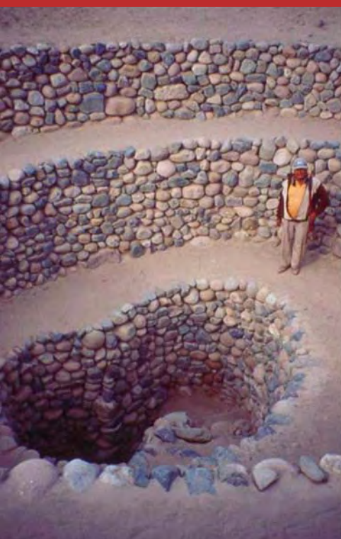
Figura 4: Nazca (costa sur del Perú). Sistema de recolección del agua de los acueductos subterráneos y alimentación de las napas freáticas.
