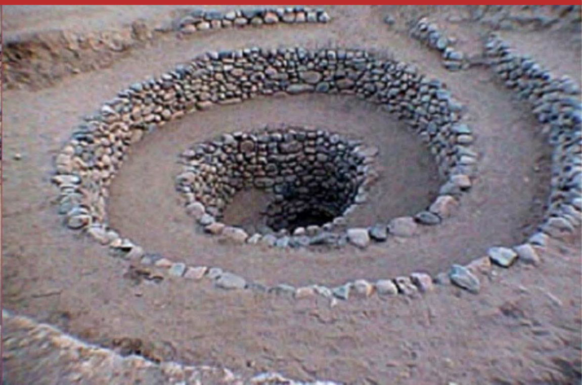
Figura 4: Nazca (costa sur del Perú). Sistema de recolección del agua de los acueductos subterráneos y alimentación de las napas freáticas.
