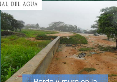
Bordo y muro en la colonia Casablanca
