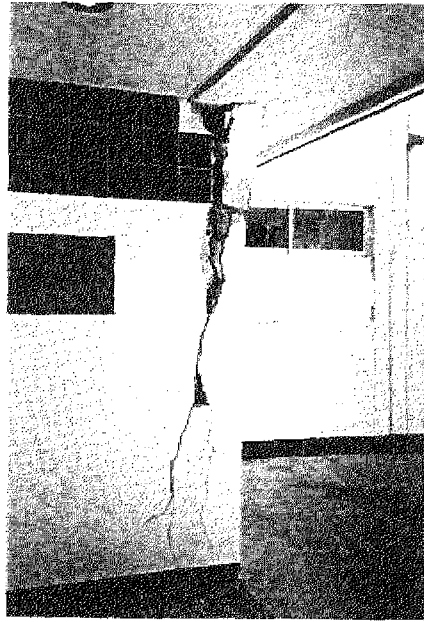
Figura 3.50 Detalle del anclaje inadecuado de un castillo en la parte frontal del edificio
