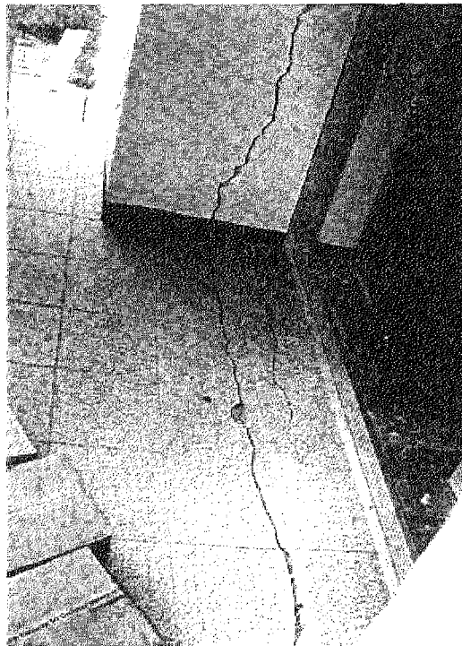
Figura 3.53 Desplomo de la columna del cuerpo III, respecto a la del cuerpo II (vista superior)
