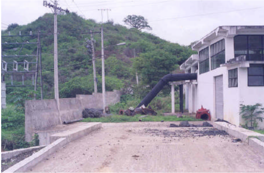
Foto 10. Muros perimetrales de hormigón para evitar inundaciones en la estación de bombeo Río de Oro. Sector estación de bombeo Río de Oro. Febrero 2000. Fuente: Macias, Ramón.
