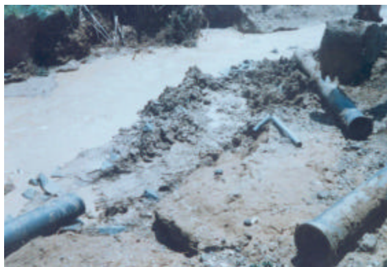
Foto 1. Rotura de la tubería de agua potable en el cruce del Río Oro. Sector Puente Río Oro, Km. 4. Portoviejo-Manta. Enero 1998. Fuente: departamento de R.R.P.P de EAPAM.
