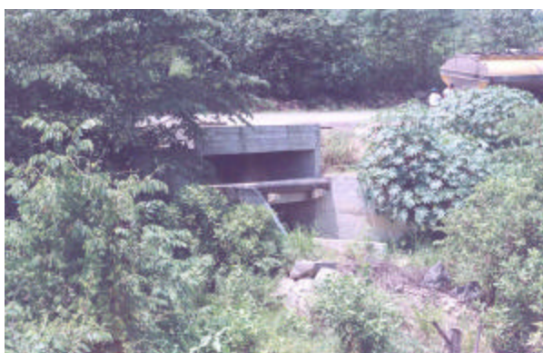
Foto 8. Acueducto reparado. Se observa la tubería anclada sobre una alcantarilla. Sector Emau. Febrero 2000. Fuente: Macias, Ramón.
