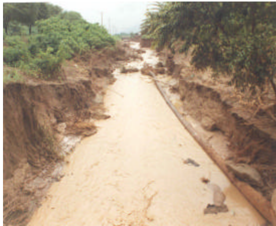
Foto 4. Tubería destruida sobre el Río de Oro. Sector entre Disensa y estación de bombeo Río de Oro. Abril 1998. Fuente: Departamento de RR.PP de EAPAM
