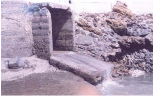
Foto 12. Alcantarilla de agua de lluvias vertiendo aguas servidas al mar. Sector Yacht Club de Manta Febrero 2000. Fuente: Macias, Ramón.
