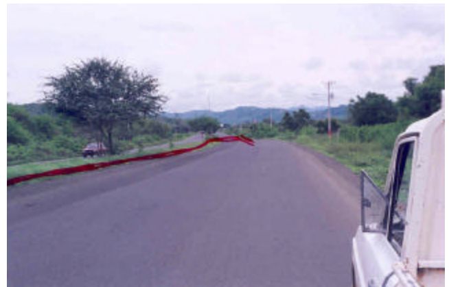
Foto 6. la zona roja indica el sector del parterre lugar en que se ubica la tubería actualmente. Sector entre DISENSA y estación de bombeo Río de Oro. Febrero 2000. Fuente: Macias, Ramón.
