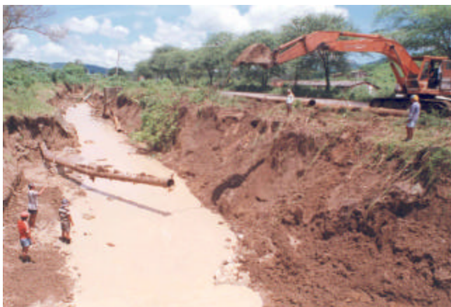
Foto 7. En este sitio la tubería recuperada se instaló desplazándola 100 metros de su eje original. Sector Emau. Abril 1998. Fuente: departamento de RR.PP de EAPAM.
