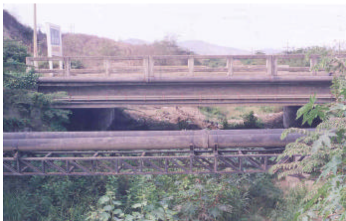
Foto 2. Ubicación y paso aéreo de las tuberías reparadas por la EAPAM. Puente Río Oro, Km. 4. Portoviejo-Manta. Febrero 2000. Fuente: Macías Ramón.
