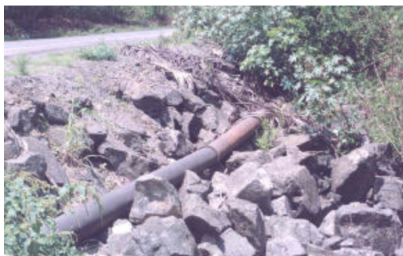
Foto 9. Tubería instalada y protegida por muros de escollera. Sector Emau. Febrero 2000. Fuente: Macias, Ramón.
