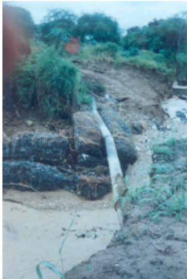
Foto 3. Destrucción de muros de gaviones y tuberías. Sector del Cerro de Hojas. Abril 1998. Fuente: Departamento de RR.PP de EAPAM
