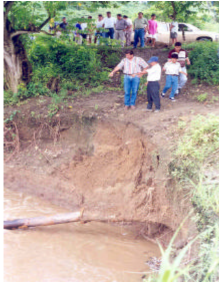
Foto 29. Tubería arrastrada y desplazada por el agua, y parte de la carretera destruida. Sector: Sitio La Tinta. Febrero 1998. Fuente: CRM -SRAPE, Zambrano, Leonardo .
