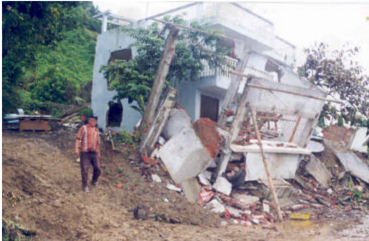
Foto 32. Se observa el deslizamiento de la ladera y la destrucción de viviendas. Sistema de Bahía. Sector: línea de conducción a Bahía, Km. 8. Octubre 1998. Fuente: CRM-SRAPE, Zambrano, Leonardo.
