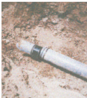
Foto 30. Tubería de PVC desacoplada por deslizamiento. Sector: Horconcito, línea de conducción a San Vicente. Octubre 1999. Fuente: CRM-fiscalización. De La Torre, Guido
