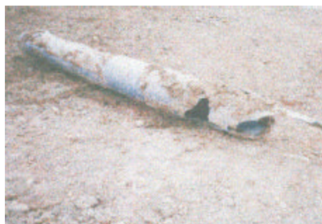
Foto 31. Tubería de PVC fallada por aplastamiento en el deslizamiento de tierras. Sector: Simbocal. Agosto 1999. Fuente: CRM-fiscalización. De La Torre, Guido
