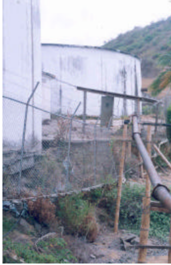
Foto 34. Tanques Gemelos, obsérvese la socavación existente, ausencia del suelo y la ubicación de la tubería, que se encuentra descubierta y reinstalada producto de los deslizamientos provocados por las lluvias, obsérvese así mismo la colocación de la tubería sobre marcos H de caña guadua y madera. Sector: Tanques de reserva de Bahía. Febrero 2000. Fuente: Macías, Ramón.
