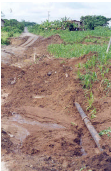
Foto 28 Tubería averiada por destrucción de carretera, ocasionado por el flujo de las aguas, obsérvese en el lado izquierdo la tubería destruida. Sector: Las Palmas- Junín.. Enero 1998. Fuente: Sistema Regional de AAPP La Estancilla CRM -SRAPE, Zambrano, Leonardo.
