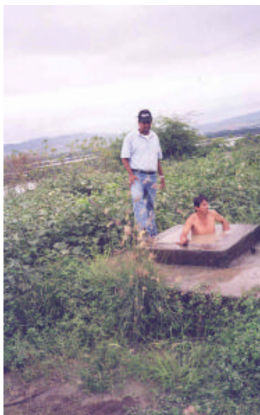
Foto 33. Cámara de válvula para derivar el agua al tanque de San Agustín, se observa al personal reparando el daño de la fuga del agua. Sector: Tanque de San Agustín. Octubre 1998. Fuente: CRM -SRAPE, Zambrano, Leonardo
