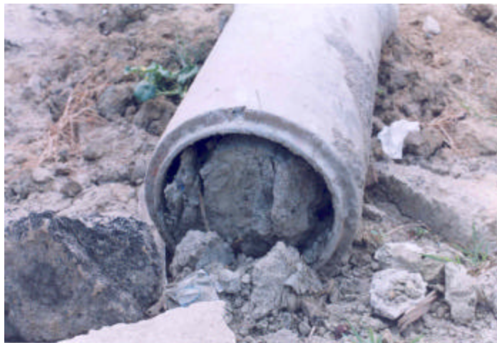
Foto 35. Taponamiento en la tubería del sistema de alcantarillado producto de la sedimentación. Red de aguas servidas. Sector: Leonidas Plaza. Mayo 2000. Fuente: Macías, Ramón.
