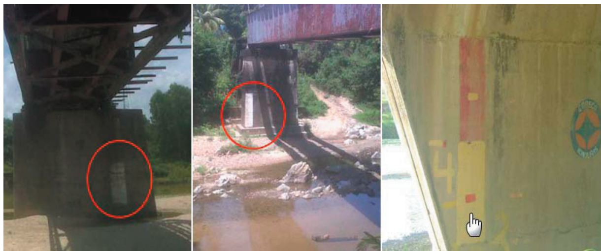
Figura 11- 4.2.2.3 Escalas pintadas en los puentes
