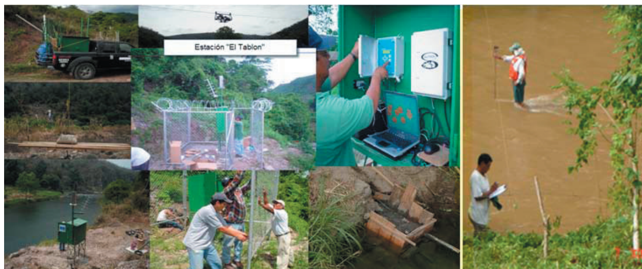
Figura 1 - 2.4 Instalación de Estaciones Telemétricas - PMDN - DGRH
