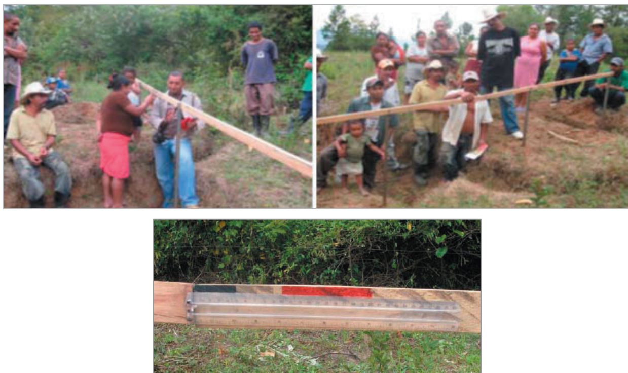
Figura 17- Instalación del extensómetro para la medición desplazamientos
